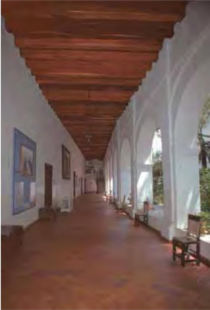
*Galería primer piso. Se observan las vigas de soporte del segundo piso colocadas en obra de restauración en el 2002.
