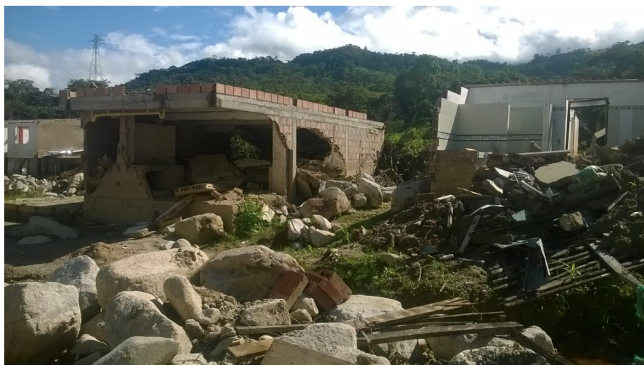
FIGURA 6. Edificaciones afectadas por rocas debido a los deslaves, 31 de marzo de 2018 Fuente: elaboración propia.
