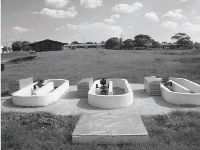
Figura 3: Tres prototipos raceway construidos y en operación con capacidad 1,2 m 3 cada uno para el cultivo de microalgas en la Unidad Acuícola del Centro Agroempresarial y Acuícola SENA. Regional Guajira
