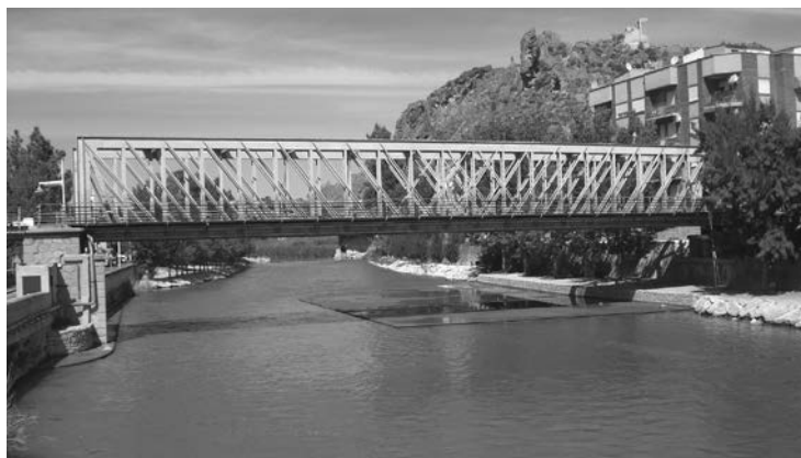
Fotografía 7. En Blanca y Negra . Puente de hierro de Blanca. Foto del autor.
