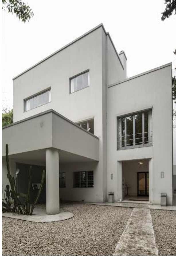
Figura 2. Detalle fachada Casa de la Cultura Fuente: Fondo Nacional de las Artes
