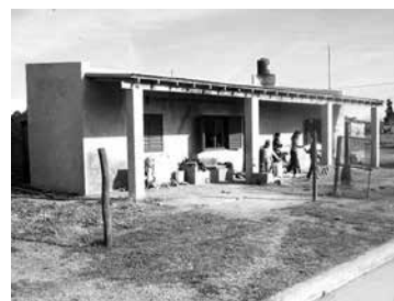
Figura 5.3. Mejoramiento habitacional en provincia de Buenos Aires
