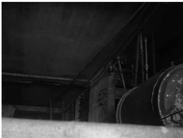
Figura 7. Patinejo en edificio de apartamentos en Centro Habana
