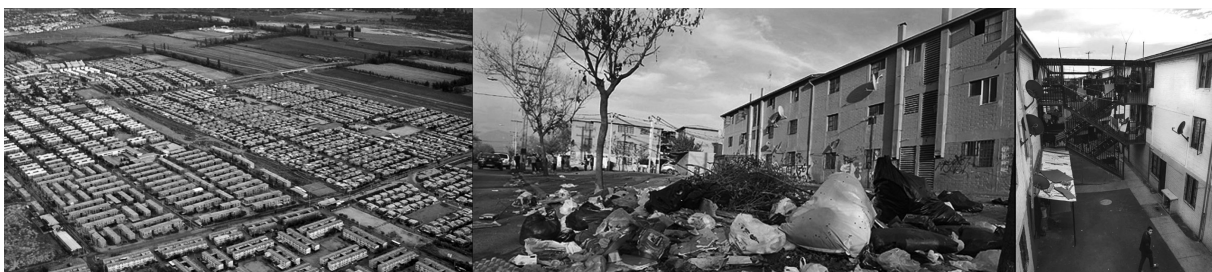
Figura 1. Sector de Bajos de Mena, en Puente Alto, una de las concentraciones más grandes de condominios sociales
