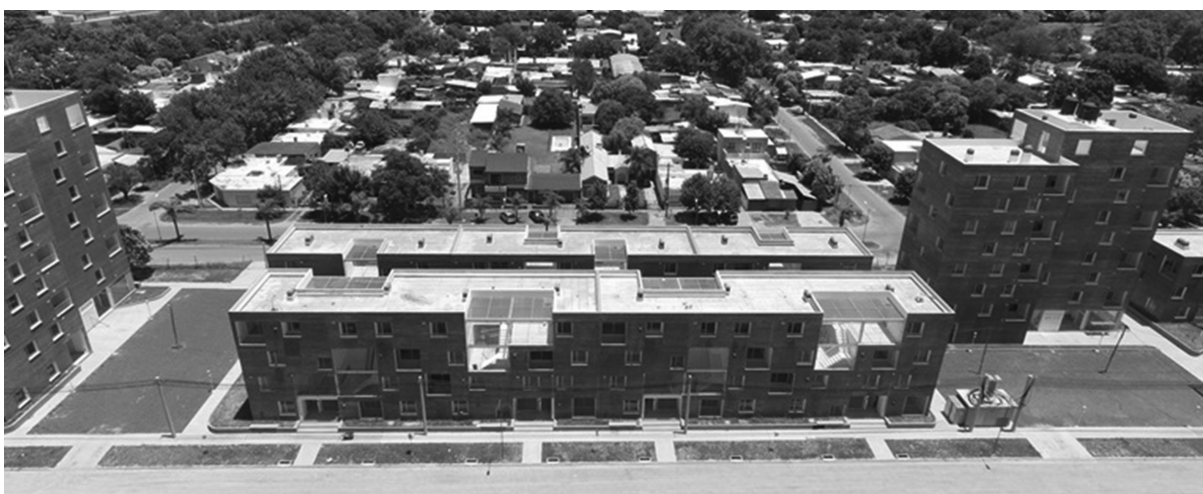
Figura 4. Obra terminada del desarrollo urbanístico ProCreAr en Granadero Baigorria
