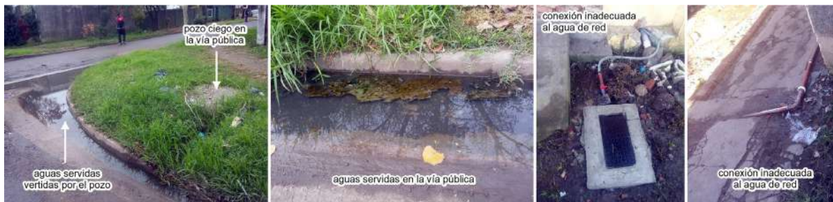
Figura 2. Aguas servidas vertidas desde pozos ciegos domiciliarios y conexiones inadecuadas al agua de red Fuente: elaboración propia
