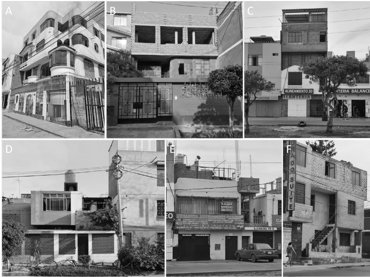
Figura 2. Fotografías de algunas viviendas muestreadas de sectores periféricos de Lima Metropolitana. Las viviendas tienen en común no haber sido concluidas y son resultado de la autoconstrucción
