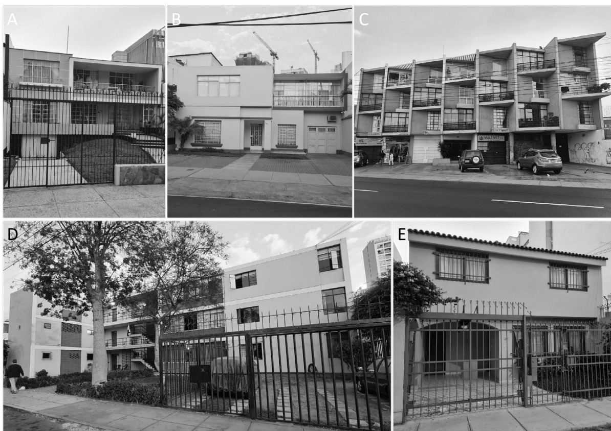
Figura 3. Fotografías de algunas viviendas muestreadas de Lima Metropolitana. Tales viviendas tienen en común haber sido planificadas y construidas formalmente
