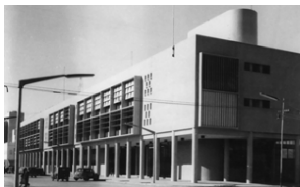
Figura 9. Edificio de Correos y Telecomunicaciones recién inaugurado (1957)
