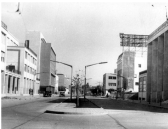
Figura 8. Vista del eje cívico desde calle Aberastain hacia avenida Rioja. En primer plano, el edificio Nueve de julio (a la izquierda) y el de Tribunales (a la derecha)
