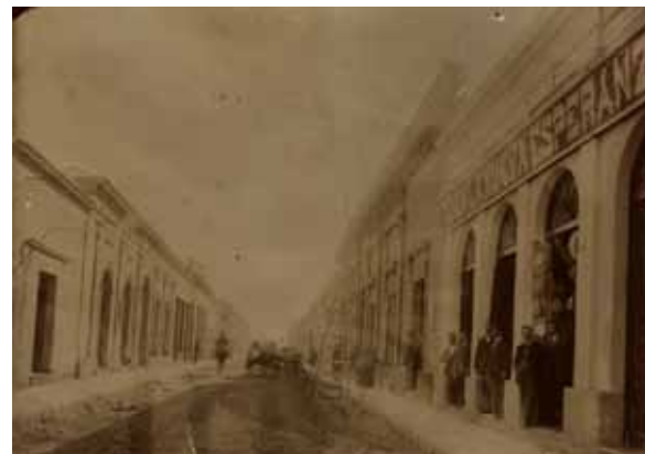
Figura 1. Vista de una calle de la ciudad a inicios de la década del ochenta
