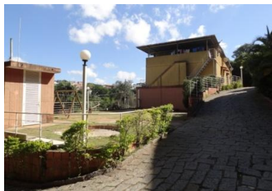
Figura 02 y 03: Viviendas en la Calle Grécia. Foto: Fabricia Zulin
