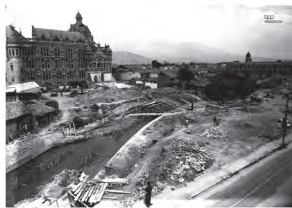
Figura 3 Foto do processo de construção do aterro. Fotógrafo Francisco Mejía (1935-1940)
