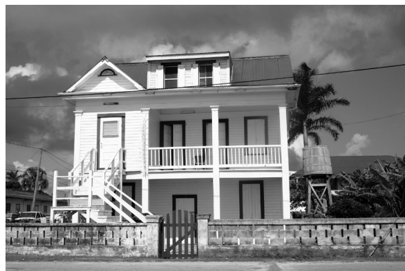
Figura 1 Fachada principal de la Schofield house en Corozal, en el norte de Belice. Se observa un pequeño curvato o depósito para el agua de lluvia a la izquierda
