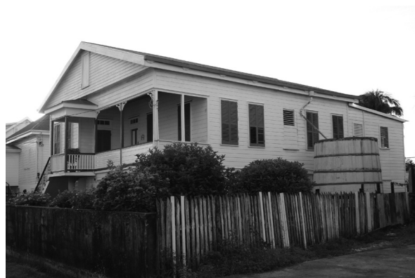
Figura 9. Casa en Cork Street en Belice City, se observa en primer término el curvato y su sistema de captación de las aguas pluviales
