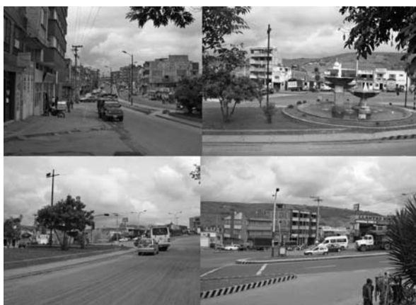
Figura 12 Sector de Los Hongos. Mezcla de usos, alturas, estado de las construcciones y materiales que se perciben sobre el eje principal de este sector
