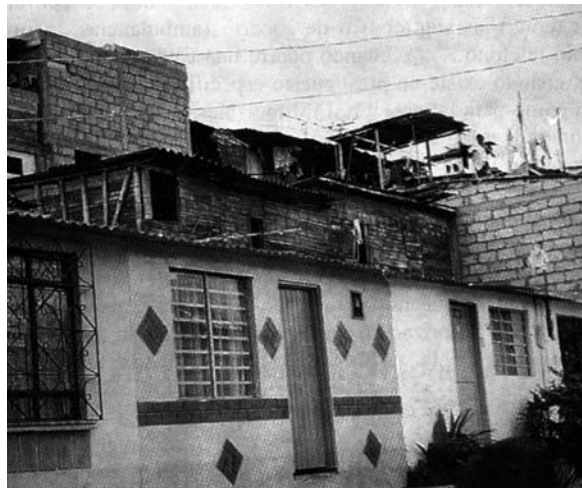
Figura 8. El barrio El Paraíso (año 1994) En el proceso de consolidación, los materiales de origen –esterilla, zinc, plástico– se utilizan para las plantas superiores.
