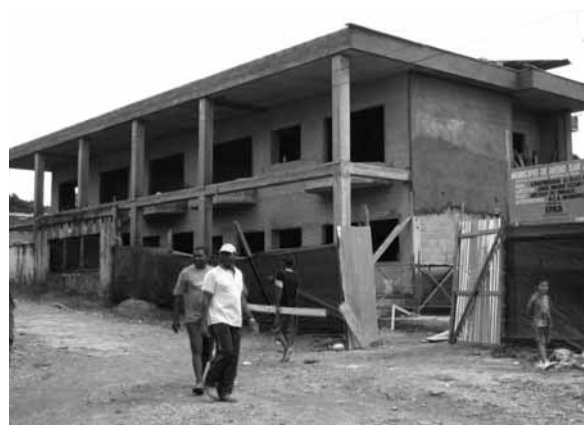
Figura 23. Construcción edificio de la alcaldía (Medio San Juan – Chocó).
