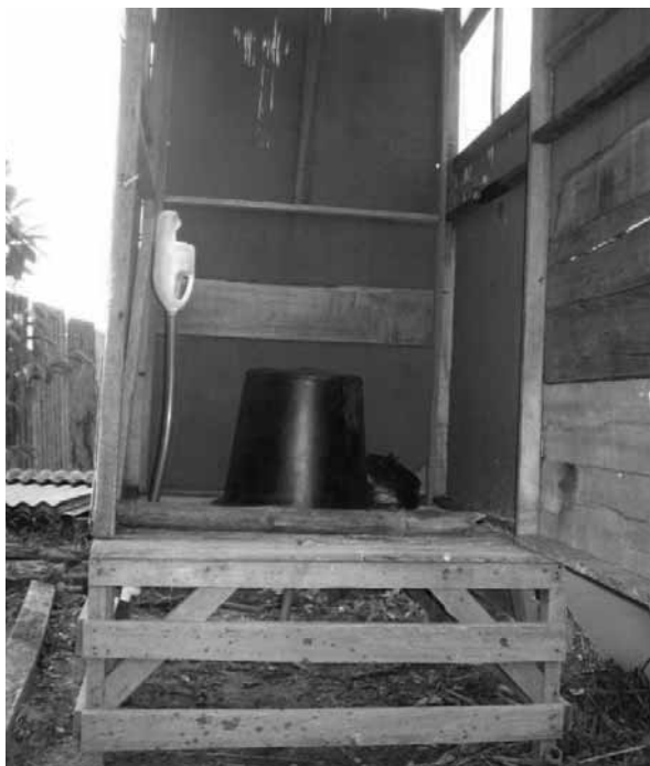
Figura 8. Sanitario Ecológico Seco instalado en el barrio Brisas del Poblado (Quibdó). Proyecto Plan Internacional.
