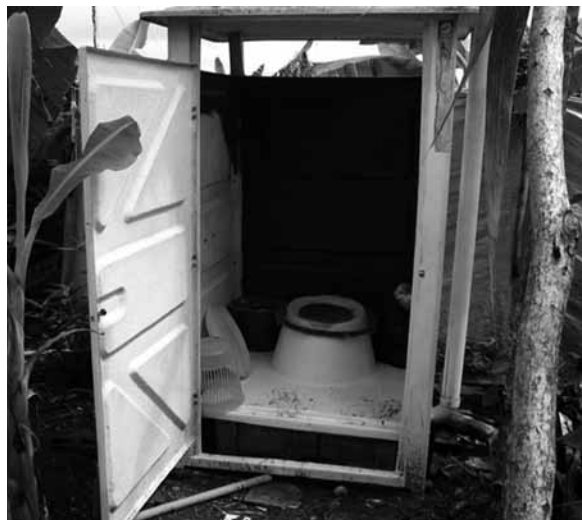
Figura 2. Sanitario ecológico seco instalado en el barrio Candamo (Tumaco).
