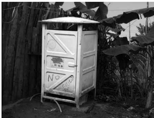
Figura 5. Sanitario Ecológico Seco instalado fuera de la vivienda. Barrio Candamo (Tumaco).
