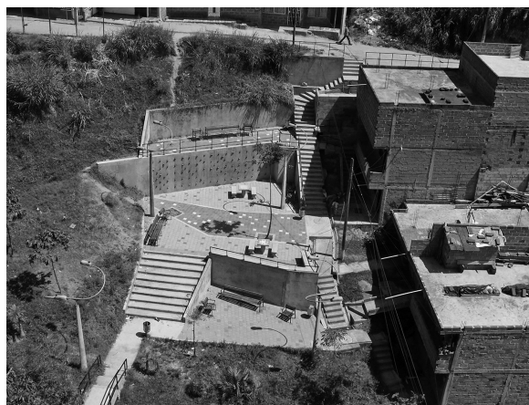
Figura 2. Obras PUI comuna 13
