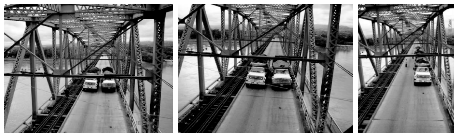
Figura 5. Condiciones de carga del puente
