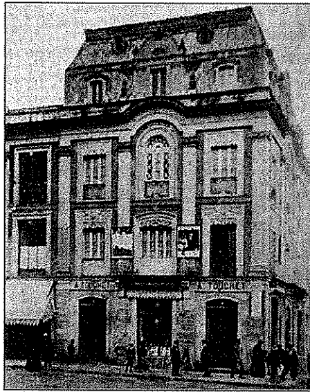
Edificio Liévano, pabellón Norte.
