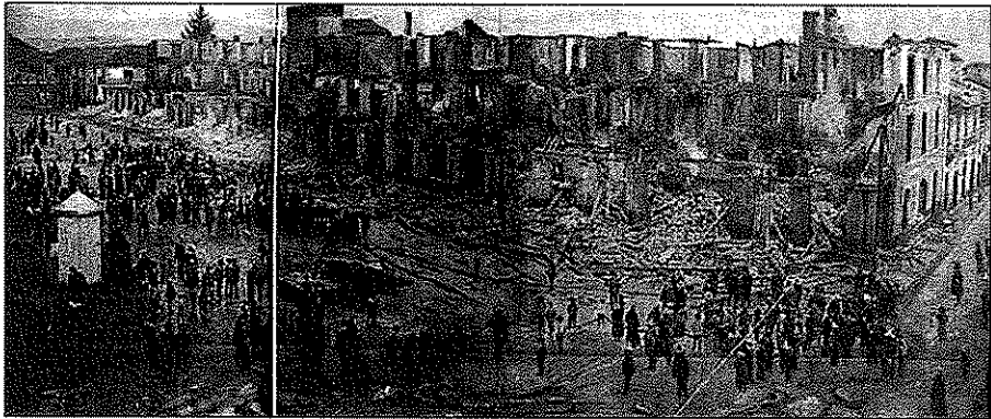
Incendio de las galerías de Arrubla.
