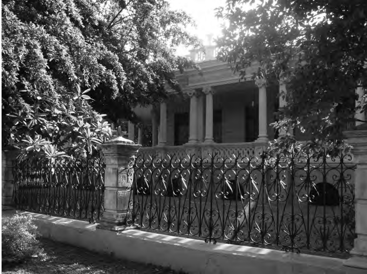
Fig. 18. Acceso principal con rejas. Trabajo de campo, Gladys Arana, 2010.
