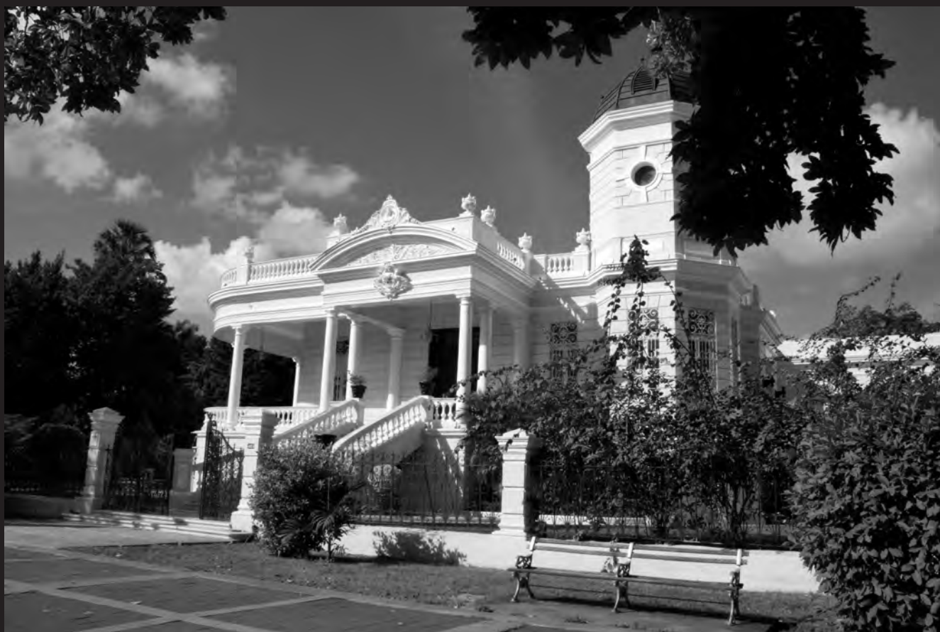
Vivienda porfiriana en el Paseo de Montejo. Quinta Montes Molina. Fotografía Gladys N. Arana López. Merida, Yucatán, México, 2011.
