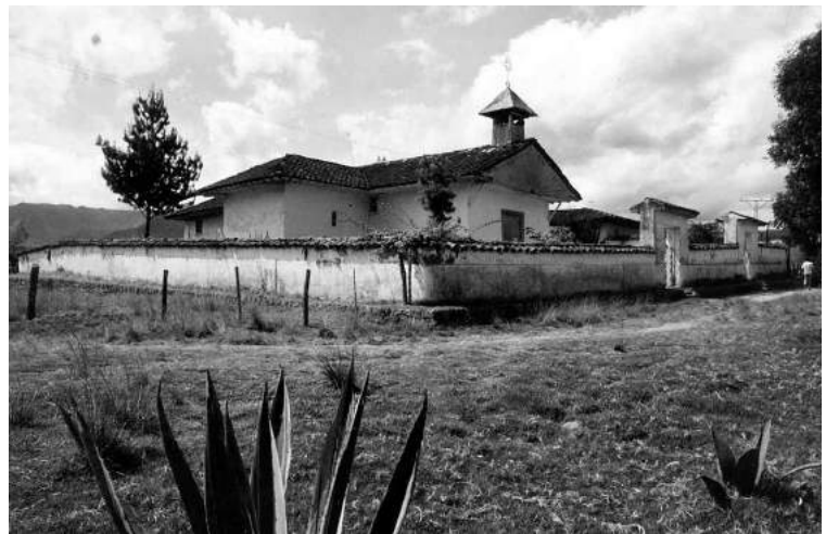
Figura 3: Vista general de la capilla, década de los años setenta. Fotografía: Darío Ruiz Gómez, 1973
