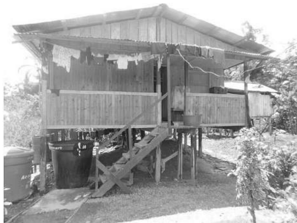
Figuras 3 y 4: Viviendas palafíticas localizadas en zonas distantes a los ríos o el mar
