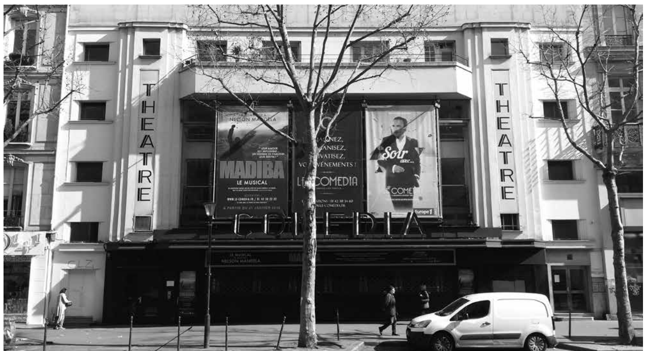
Figura 13: Fachada del Théâtre Le Comédia en 2016 (antiguo cinema Eldorado), sobre el Boulevard de Strasbourg Fotografía: Andrés Ávila
