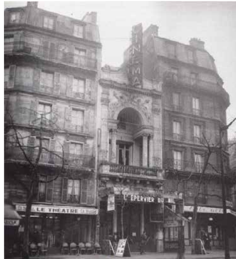
Figura 12: Fachada del cinema Eldorado en 1934
