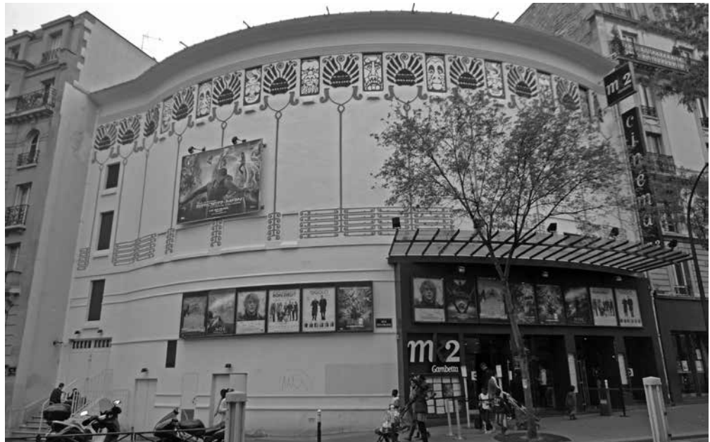
Figura 16: Fachada del MK2 Gambetta en 2015, esquina de la Rue Belgrand y la Rue du Cher Fotografía: Andrés Ávila
