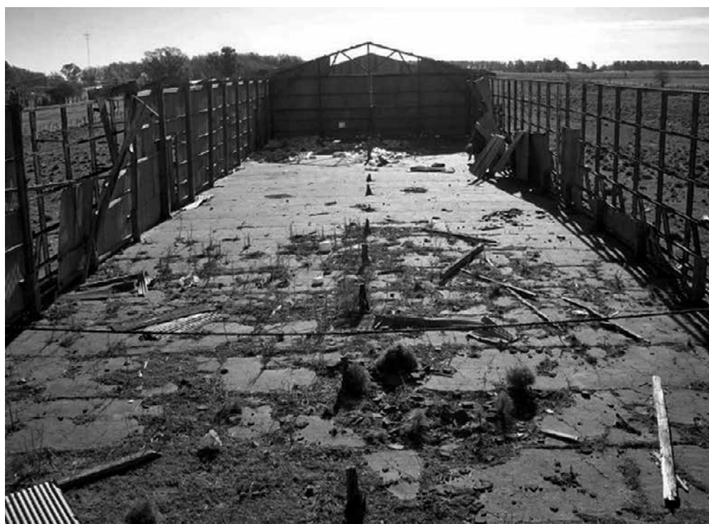
Figuras 5 y 6: Antiguo galpón de acopio Fuente: Registro propio (2014)
