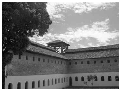
Figura 11: Edificio durante el proceso de restauración. Fuente: Mario Cifuentes
