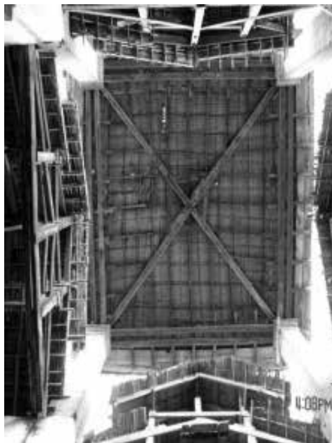
Figura 26: Estructura de cimborrio.
