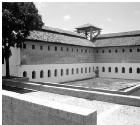
Figura 30: Vista del estado actual del edificio restaurado.
