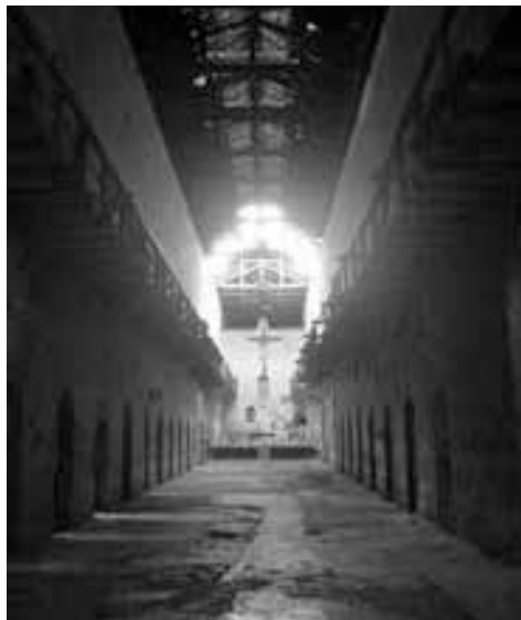
Figura 10: Estado del edificio antes de su restauración. Fuente: Mario Cifuentes
