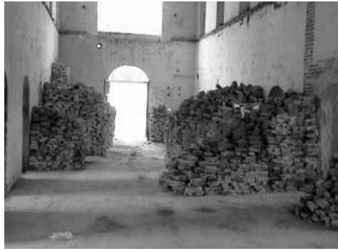
Figura 18: Liberación de muros no originales.
