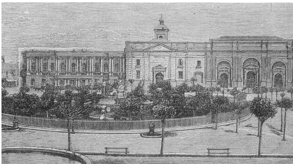
Figura 2: Plaza de Armas, ca. 1872 con el nuevo Palacio en construcción. Fuente: Chile Ilustrado: Guía Ilustrado [sic] del Territorio de Chile, de las Capitales de Provincia I [sic] de los Puertos Principales, por Recaredo S. [sic] Tornero. Obra adornada con 200 grabados en madera i [sic] diez litografías a dos tintas (p. 34). Valparaíso: Librerías i [sic] Agencias [sic] del Mercurio. Colección Ignacio Julio Montaner.
