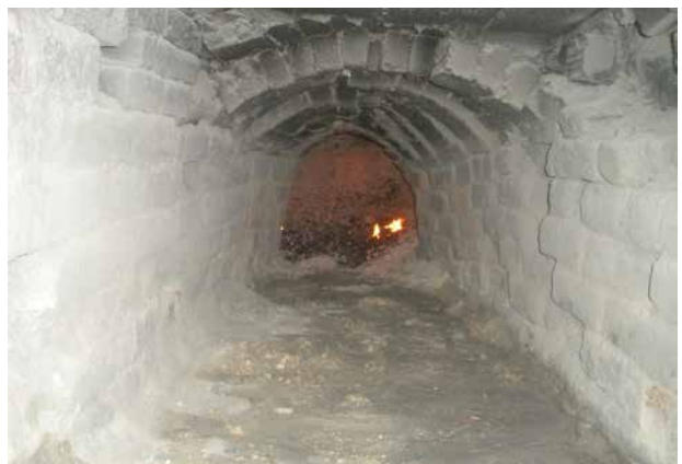
Figuras 5 y 6: Parrilla y cárcamo de un horno de colmena. Fotografía: Elaboración propia
