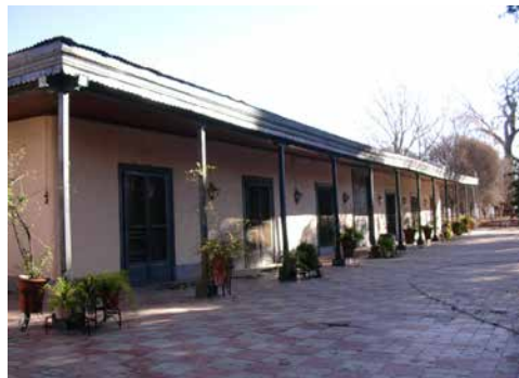
Figura 13: Casa patronal Bodega Panquehua, Las Heras (1864).
