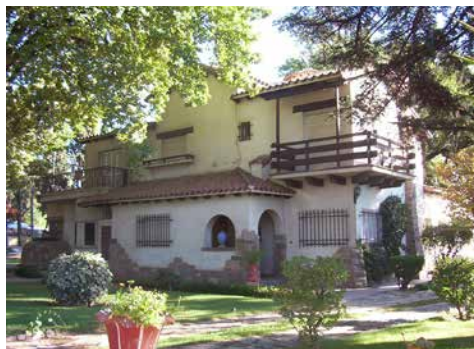
Figura 31: Chalet suburbano en Maipú, planta compacta irregular. Fuente: Proyecto PICT 13 - 14022, dirigido por Silvia Cirvini
