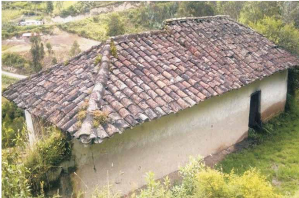
Figura 31: Vivienda en la zona rural del municipio de Gualmatán, prototipo de forma rectangular, con cubierta en teja de barro a cuatro aguas, muro en tapia pisada pañetado en suelos cohesivos y fibra orgánica equina. Fuente: Esta investigación. Fotografía: arq. Juan Carlos Figueroa
