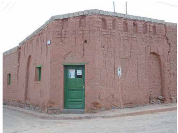
Figura 6: Imágenes de la construcción 1 en 1970 (izq.) y en la actualidad (der.) Fuente: Federico Ortiz ,1970 (izq.), y Julieta Barada (der.)
