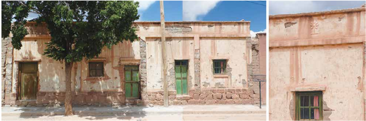
Figura 10: Fotografía de fachada de la casa 2, a la derecha el detalle decorativo en el friso.
