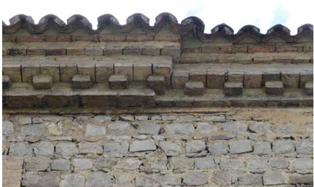
Figura 4: Mampostería de Santa Clara, detalle de cornisa en mampostería
