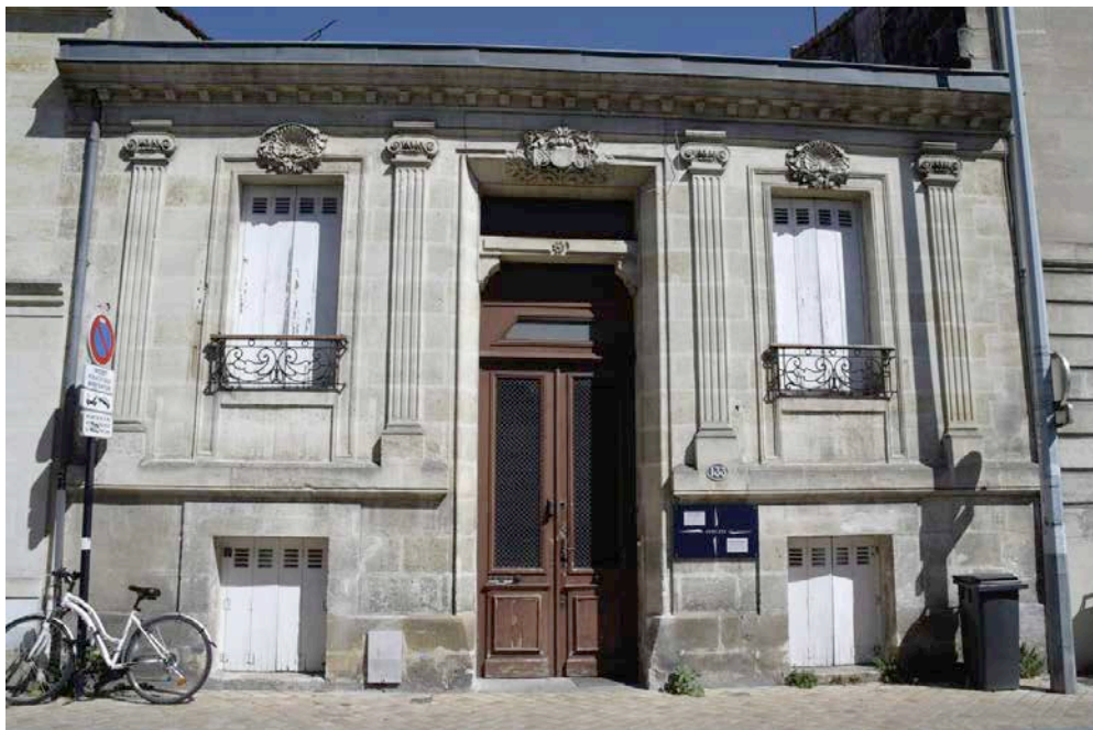
Figure 4 : Échoppe double élevée sur cours, 133 rue Lecocq à Bordeaux Photo : Linda Gonzalez-Lafaysse, 2017.
