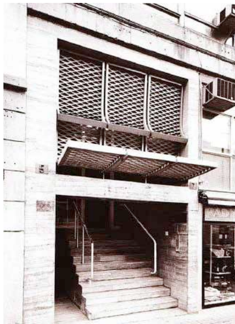
Fig. 17-18 : Édifice d'Alejandro de la Sota, façade rue Prior. Façade d'origine (1965); Source Fig. 17: Salamanca guía de arquitectura, 2001, p.181. Etat actuel (juin 2015); Source Fig. 18: Milena Crespo, 2015
