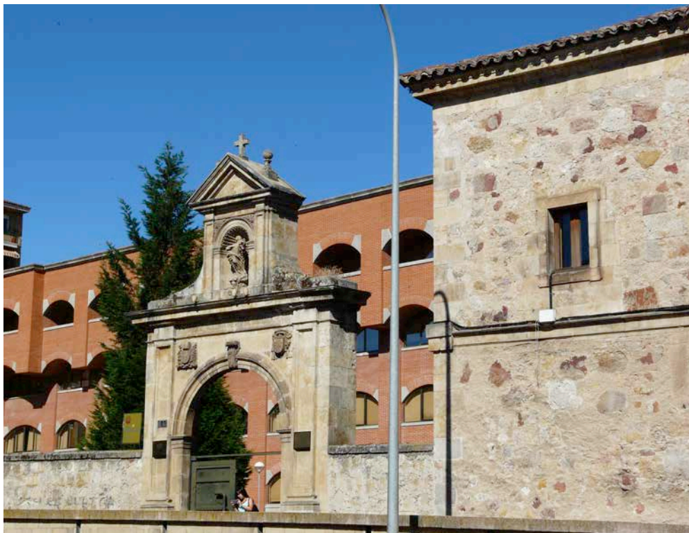
Fig. 14-15 : vues actuelles des trois bâtiments du campus.
