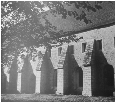
Fig.9a et 9b : Abbaye de l'Epau, façade est du bâtiment des moines avant et après restauration (MHF, 1, 1973, 16-17)
