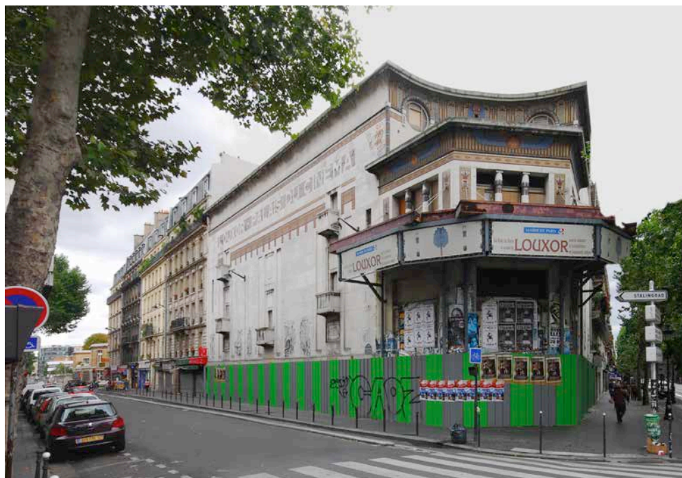
Figura 1. Estado de las fachadas del Louxor en 2007 (Fotografía: Art Graphique et Patrimoine)
