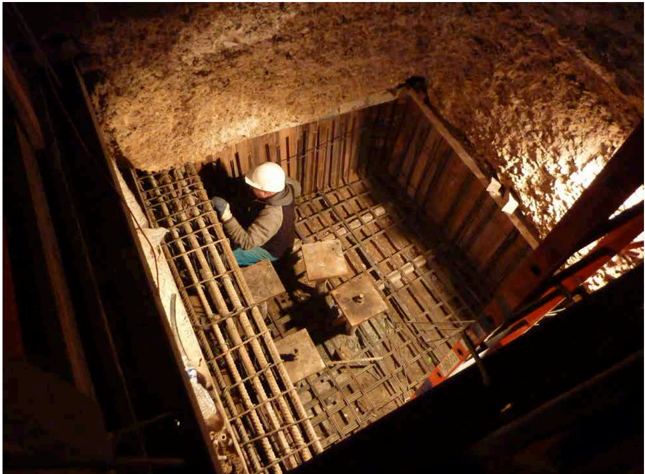
Figura 33 (página anterior) y figura 34 (en esta página). Trabajos de cimentación previos a la rehabilitación, en donde se aprecian las cabezas de micropilotes. (Fotografías: Philippe Pumain)
