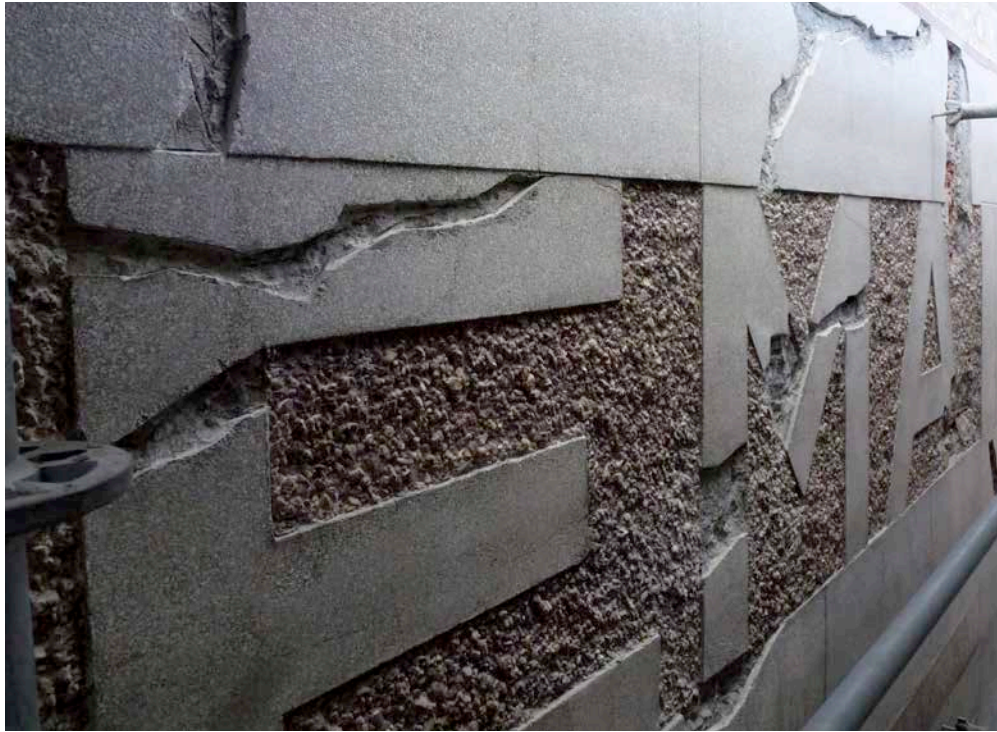
Figura 39. Restauración de capas de granito en las fachadas (Fotografía: Philippe Pumain)
