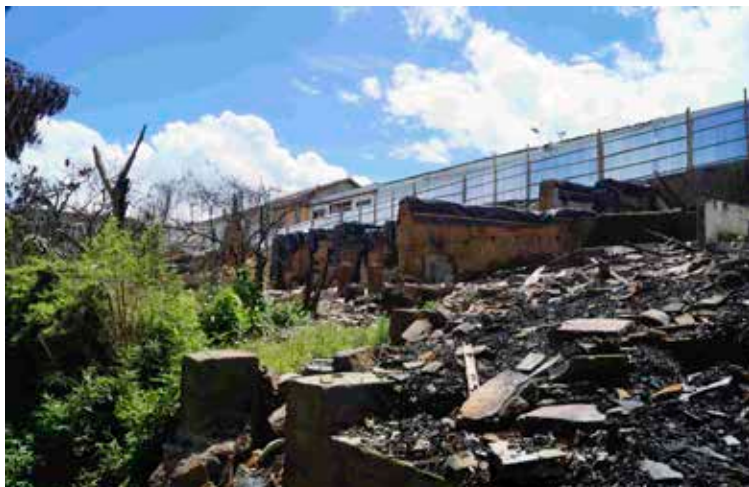
Figura 2. Ruinas del incendio de Salamina Fuente: elaboración propia
