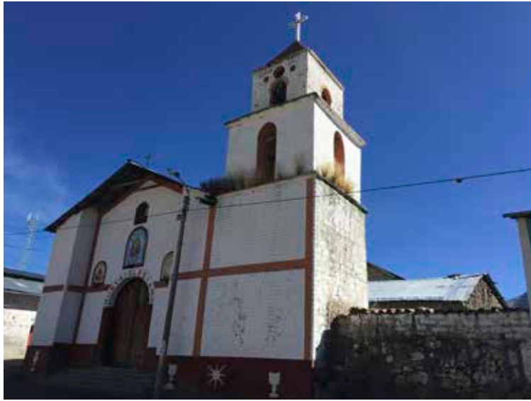
Figura 8. Fachada de la iglesia de Chipao Fuente: elaboración propia (2017)
