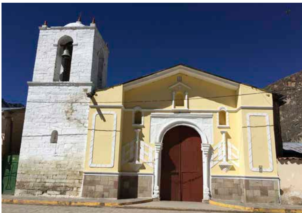
Figura 7. Fachada de la iglesia de Andamarca
