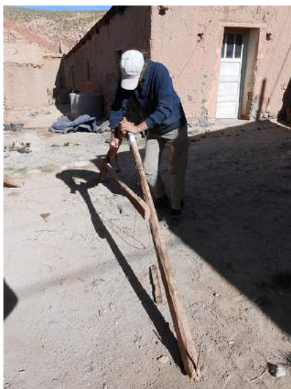
FIGURA 10. Proceso de armado de las tijeras Fuente: elaboración propia
