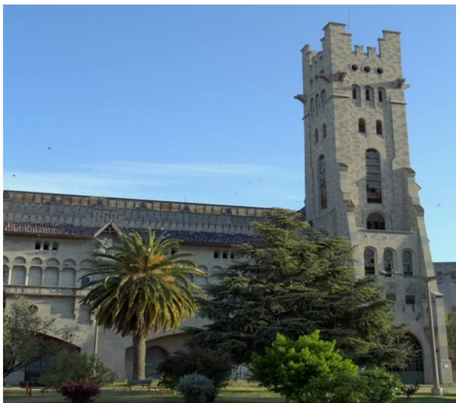
FIGURA 7. Ex Usina Eléctrica General San Martín Fuente: Cristiano (2019)
