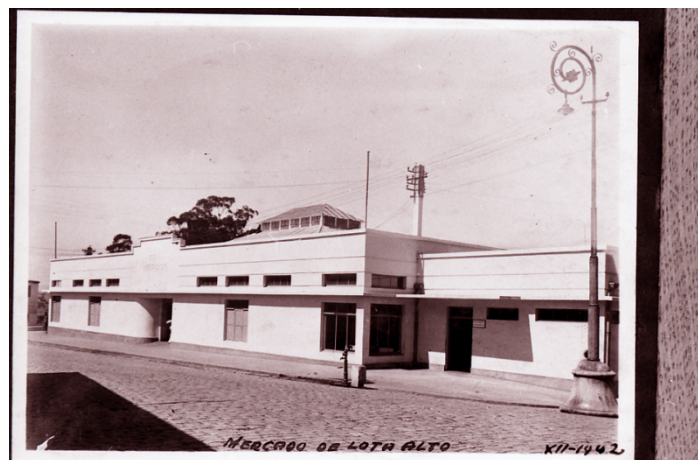
FIGURA 19. Mercado de Lota Alto, Arquitecto Eduardo Knockaert Fuente: Enacar.
