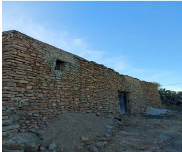
FIGURA 1. casa rifeña rustica Fuente: elaboración propia.
