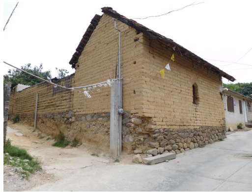
FIGURA 3. Sobrecimiento o rodapié, muros y cubierta de la casa de adobe Fuente: archivo de Fabiola B. Herrera Rivas, 2018.
