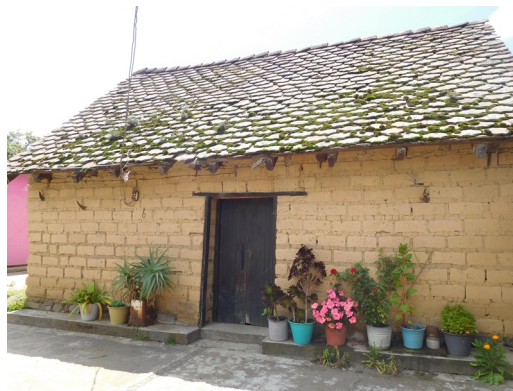
FIGURA 4. Cubierta de teja plana orlada roja recocida apoyada sobre la armadura de vigas de madera Fuente: archivo de Fabiola B. Herrera Rivas, 2024.
