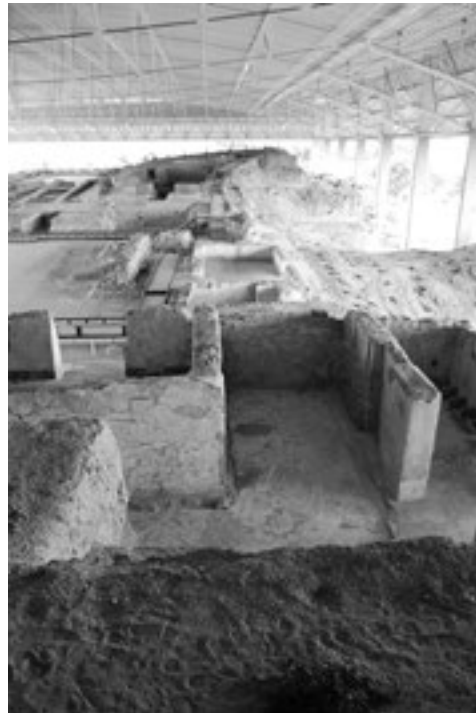
Figura 6: Además de su impacto en el paisaje, la cubierta de 11.000 m 2 del sitio arqueológico de Cacaxtla, México, ha sido causa de deterioro del patrimonio construido con tierra.
