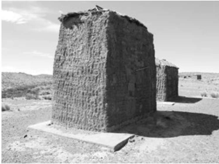
Figura 5: Uso de adobes y madera para reforzar los muros originales de pajarcilla que caracterizan a las chullpas de Chacarilla, Bolivia.
