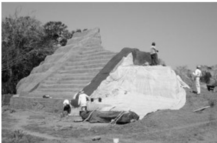
Figura 8: Colocación de un geotextil y recubrimientos de sacrificio sobre los restos de la fachada de la pirámide de La Joya, México. Fotografía: L. Guerrero
