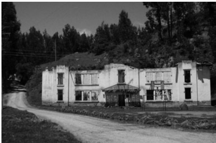
Figura 2: Estación de pasajeros de Mogua y su contexto. Ferrocarril del Norte, Km 76. Fotografía: Carlos Eduardo Nieto, 2009.
