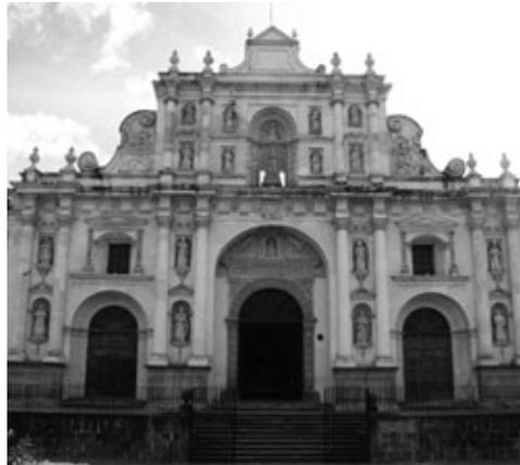
**Figura 5:** Fachada Catedral (1680), arquitecto Joseph de Porres. Destaca el orden gigante de las columnas adosadas que definen el primer cuerpo, la transformación de los triglifos de tres a seis barras y la introducción de otros elementos decorativos, como el escudo papal y la concha que identifica al Apóstol Santiago.
