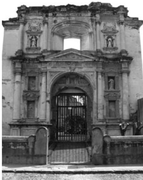
**Figura 11:** *Fachada Santa Teresa (1687), arquitecto Joseph de Porres, al igual que en la Compañía de Jesús, destaca la puerta principal con una portada que sobresale hasta el rostro exterior de las columnas adosadas, haciendo que el entablamento también sufra ese desplazamiento hacia el frente.*
