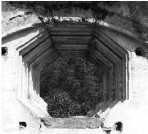
**Figura 16:** Ventana octogonal en el interior de la Recolectión, cuyos derrames están trabajados con molduras, como si se tratara de un trabajo de carpintería.
