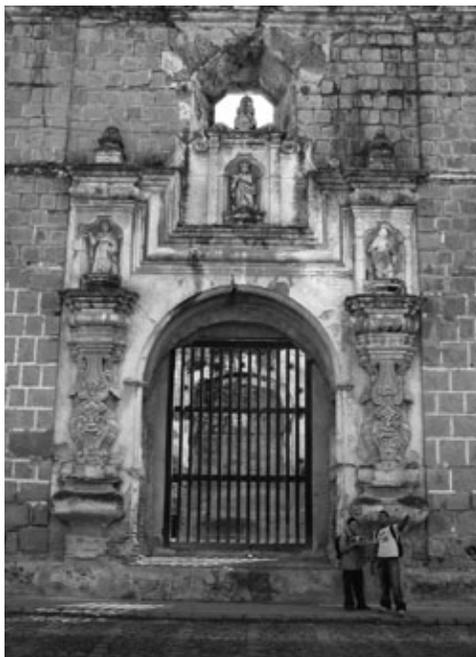
**Figura 18:** Detalle portada lateral Santa Clara (1734), de Diego de Porres. Dentro de la sobriedad de la fachada de piedra, destaca la portada trabajada en estuco y dentro de esta, las pilastras abalaustradas serlianas que dan apoyo a hornacinas con dintel poli lobulado. Nótese la magnífica composición del entablamento curvo sobre las hornacinas que baja para dar lugar a la hornacina central y salvar la ventana octogonal, sobre el eje central.
