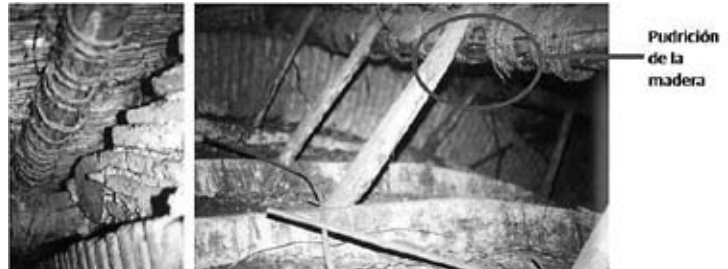
iglesia de San Ignacio. Para realizar ésta unión se emplearon clavos de forja.
