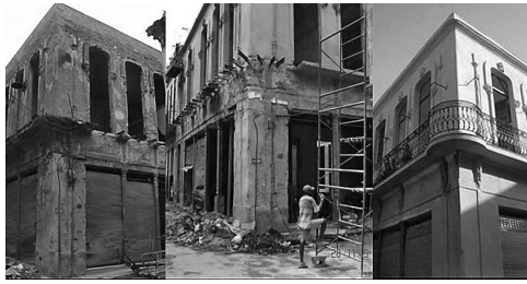
Figura 4: Secuencia de rehabilitación de la edificación ubicada en la calle Paula entre Habana y Compostela. Habana Vieja. Fotografía: Abel Pérez.
