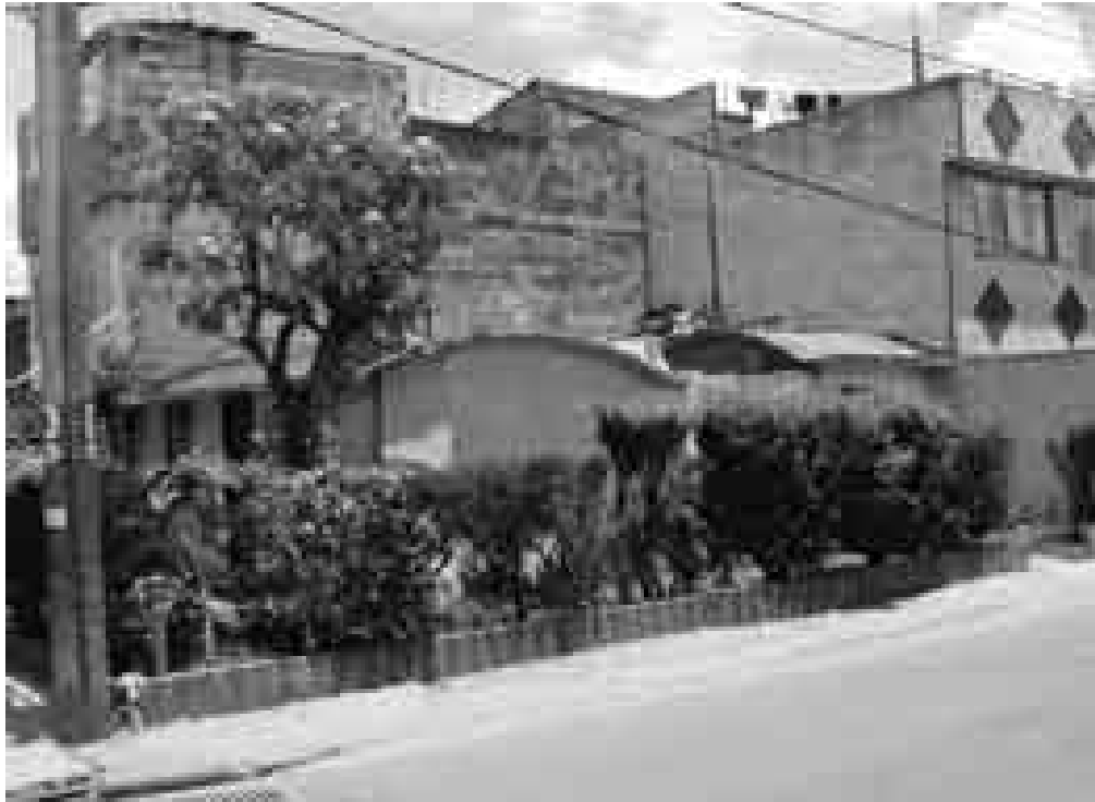
Figura 12: Barrio Quiroga, Instituto de Crédito Territorial, 1951-1962. Esfuerzo estatal para proveer vivienda a las familias de escasos recursos. Fue notable el aporte técnico de construcción mediante la experimentación con paneles y bóvedas en concreto, prefabricados en sitio e izados por ventosas. Queda muy poco de las escasas viviendas que han sobrevivido como testimonio de ese interesante ensayo.
